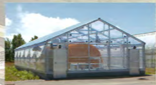
⑨余剰熱供給施設
